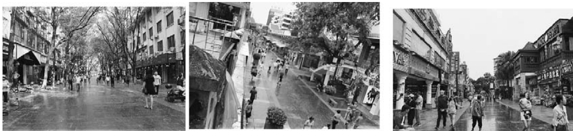
写真6.3 桂林市・正陽路歩行街 左：並木 中：2階歩廊からの眺め 右：建物構造（1、2階の増築）
